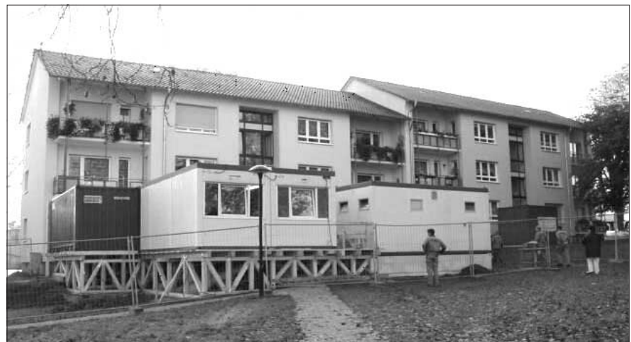
Abb. 2: Baustelle während der ersten Phase der Dekontamination der Wohnung in Landau
