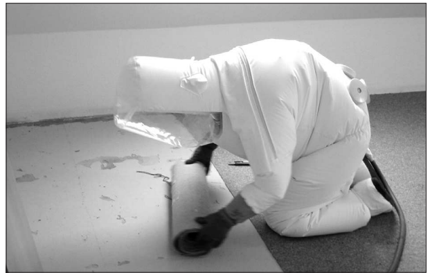
Abb. 3: Dekontamination in der Wohnung in Eschbach, Entfernung von kontaminiertem Teppichboden
