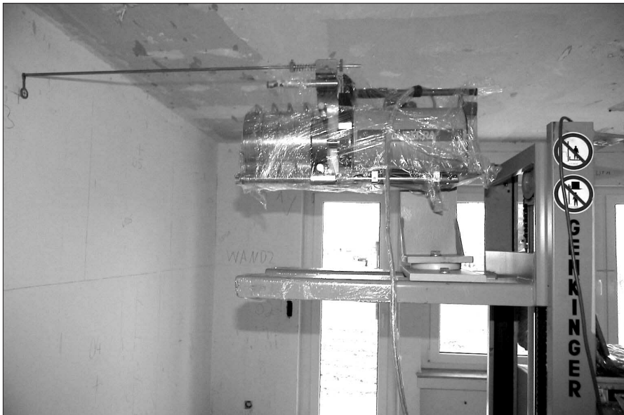
Abb. 4: Freimessung in der Wohnung in Landau
