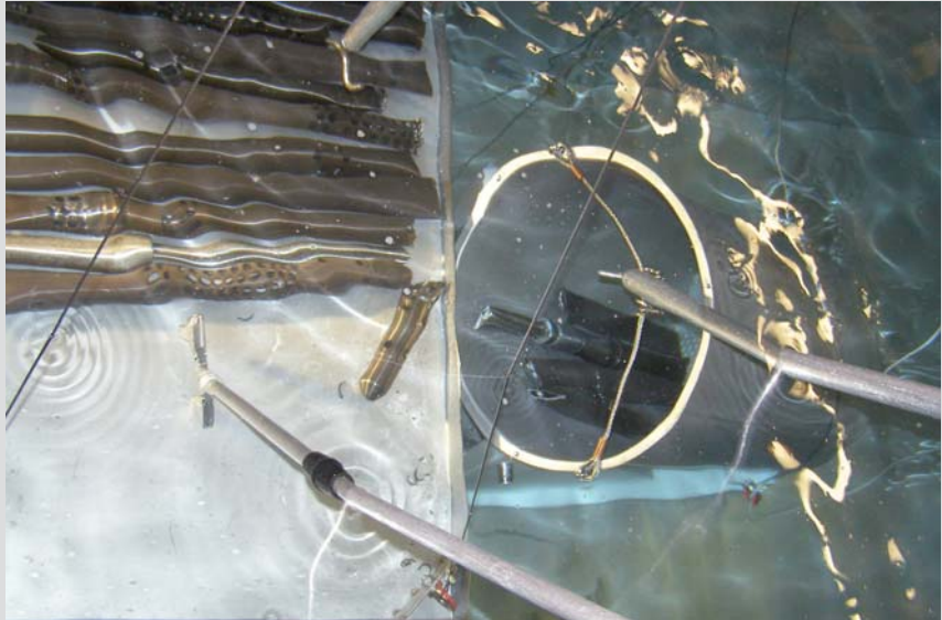
Umladen der RDB-Füllstandssonden-Abschnitte in einen fassgängigen Eimer.
